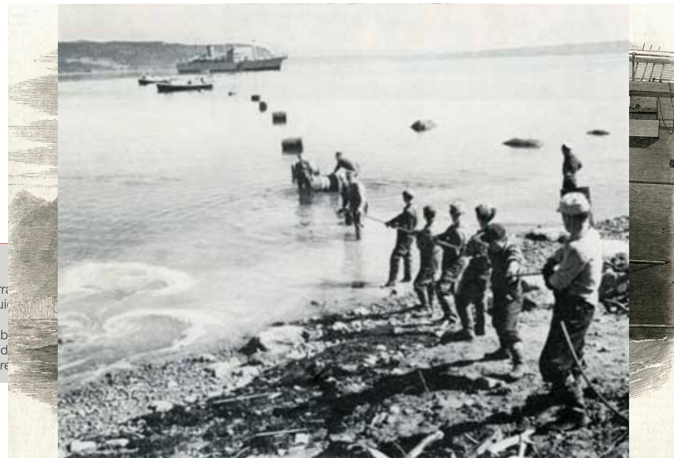
Em Casimiro Neves, o cabo de aço do "Niagara" em tambores e é puxada para terra do navio.
